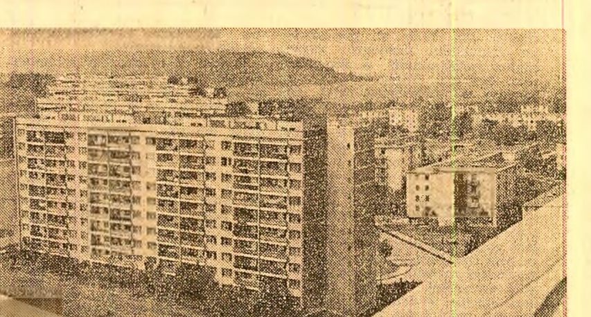
Intr-un oraș nou - cum este Gheorghe Gheorghiu-Dej - construcția de locuinte va cunoaște și in acest an o puternică dezvoltare
