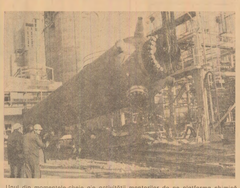
Unul din momentele-cheie ale activității montajului de pe platforma chimică Arad: sub o atenție supraveghere este înălțată o colană de sinteză
