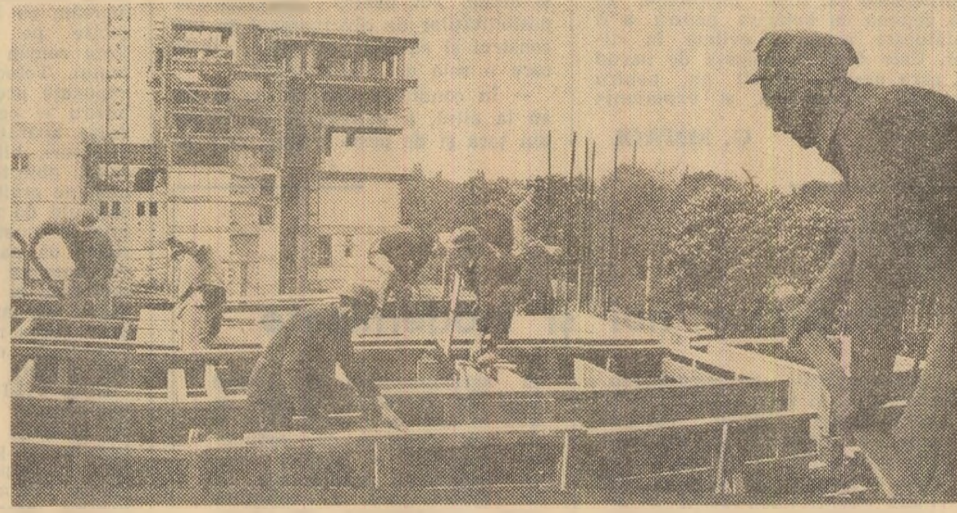
Pe șantierul dezvoltării întreprinderii „Tînră Gardă” din Capitală se lucrează din plin pentru realizarea înainte de termen a noilor obiective. Foto: E. Dichisescu
