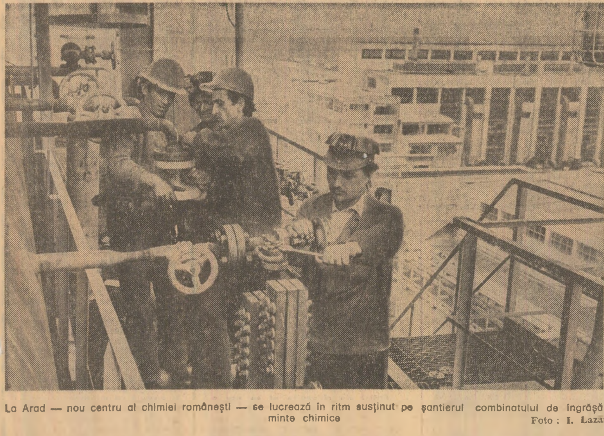
La Arad — nou centru al chimiei românești — se lucrează în ritm susținut pe șantierul combinatului de Îngredîmînt chimice Foto: I. Lazăr
