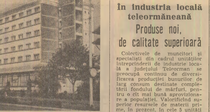
Vedere din Cimpulung Foto: S. Cristiana
