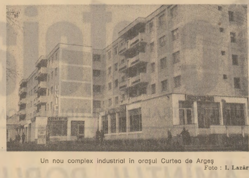
Un nou complex industrial în orașul Curtea de Argeș. Foto: I. Lazăr
