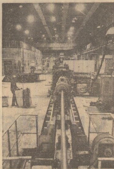
Întreprinderea metalurgică din Iași: aspect din hala laminatoarelor
