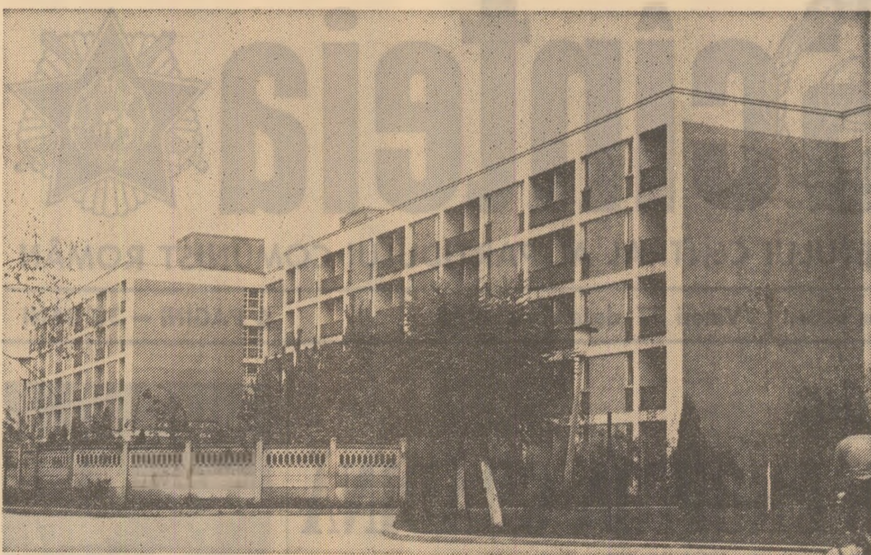
Spitalul unificat din orașul minerilor, Motru
