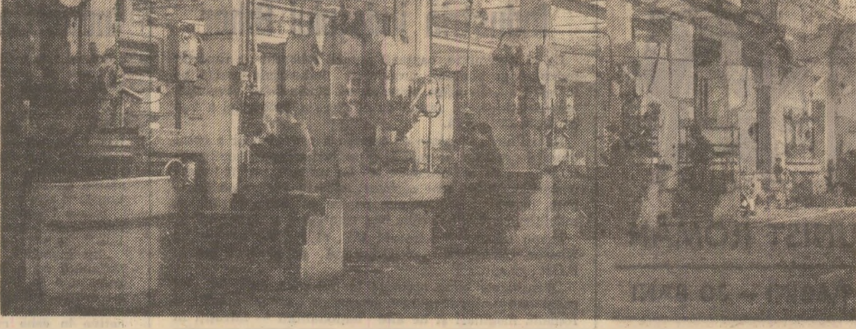
Aspect dintr-o secție a întreprinderii de utilaje și piese de schimb Suceava
