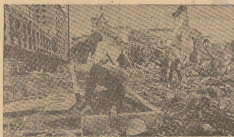
Beirut. Se lucrează intens la degajarea căilor centrale de circulație ale capitalei libaneze. O imagine simbolică pentru eforturile de reconstrucție a țării devastate de război
