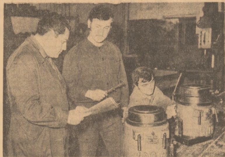
Maistrul principal Ion Sirbu, șeful de echipă Marin Dima și muncitorul Vasile Tudorache pregătesc pentru expediere la beneficiarii noile circuiți hidraulice de 100 tone-forță
