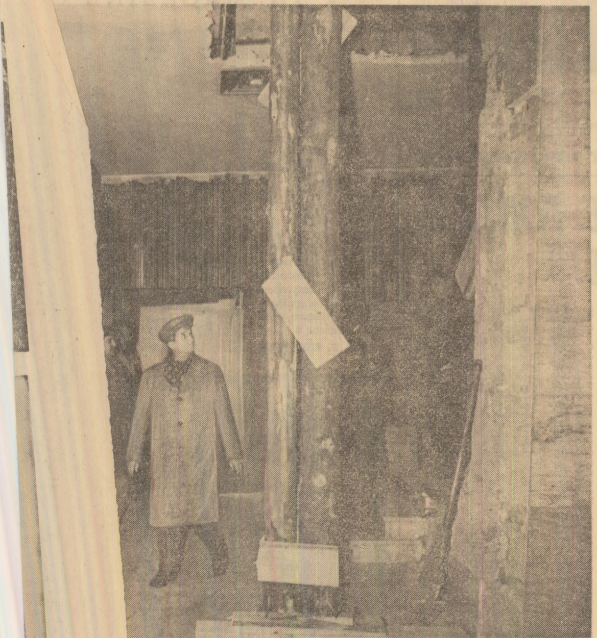
Este urmărită acțiunea de consolidare a unor edificii
