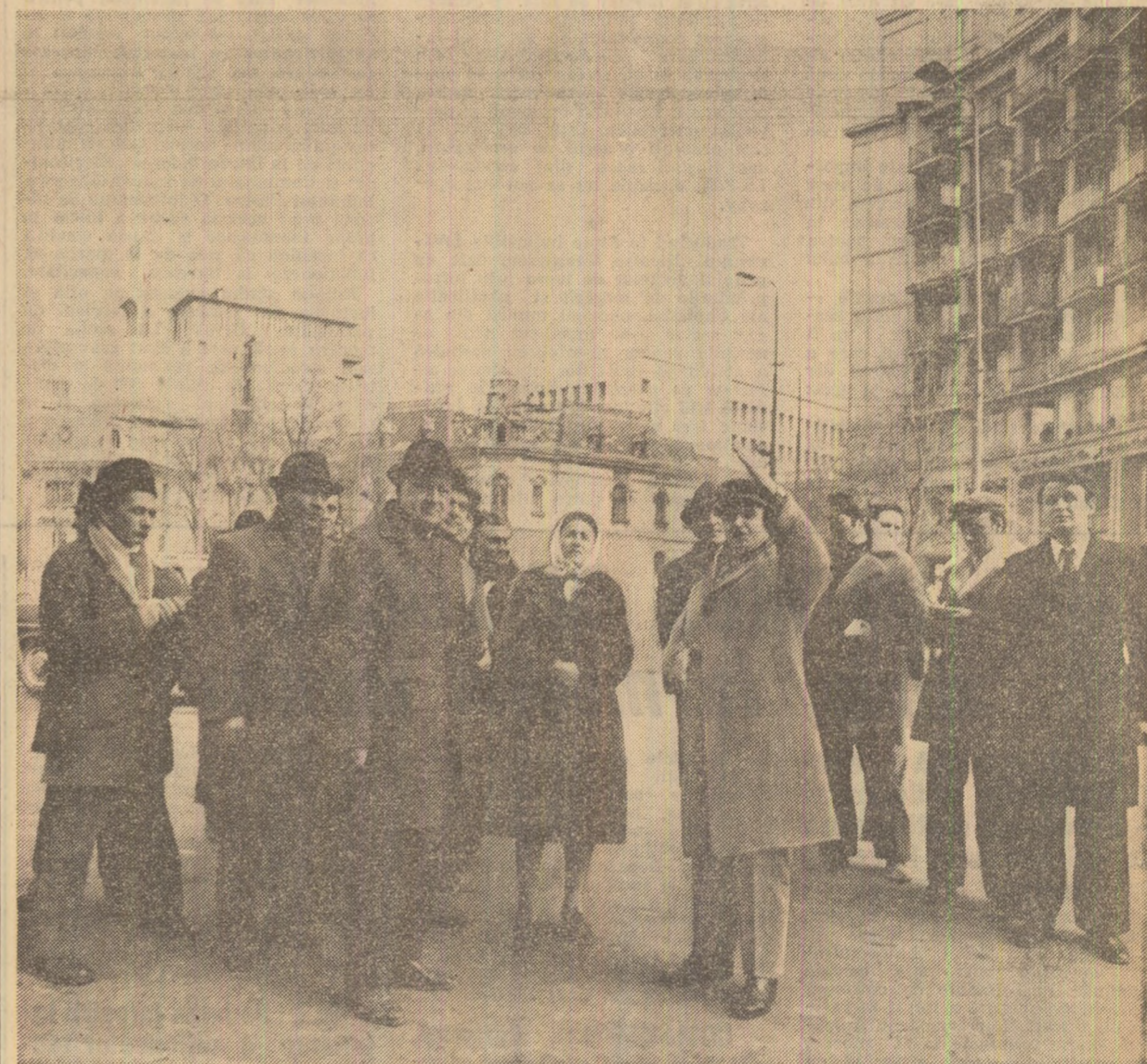
Se analizează, la fața locului, soluțiile pentru consolidarea clădirilor deteriorate
