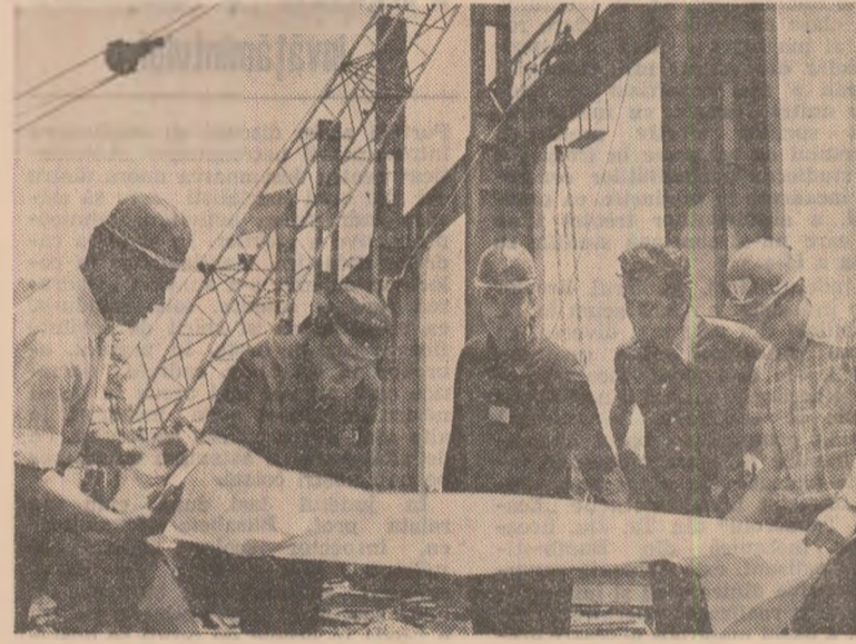
Inginerii Gheorghe Damian, Nicolae Ioana, Constantin Barabos, maestrul Stefan Iordache și secretarul comitetului de partid, tehnicianul Badea Busuic, analizează la fața locului stadiul lucrărilor de construcție la hala mecatului nr. 7
