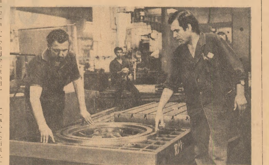
Pe adresa întreprinderii mecanice din Roman, care a livrat întreprinderii de mașini-unelte din Bacău o masă rotativă (în imagine) cu defecte de turnare
