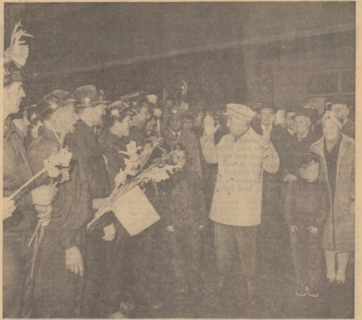
Tovarășul Nicolae Ceaușescu și tovarășa Elena Ceaușescu în mijlocul minerilor suceveni
