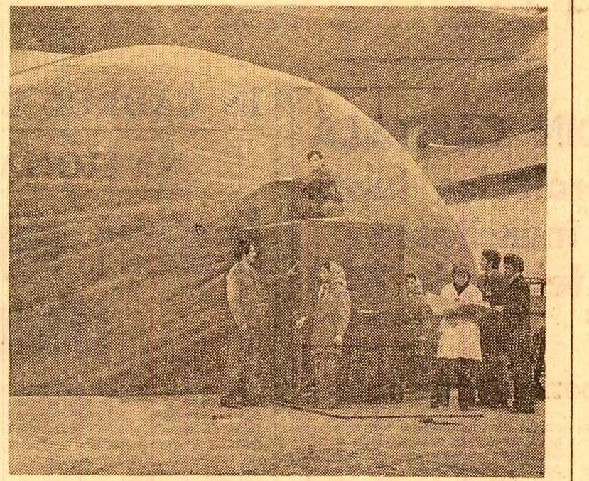
Magazia din pinză gonflabilă atinge 40 metri diametru și 12 metri înălțime, este practic, ușoară și ieftină în comparație cu depozitele, ce presupun materiale de construcție și mină de lucru. La cerere, combinatul execută asemenea cupole pentru acoperirea de săli de gimnastică și alte terenuri de sport, pentru alte îmbunătățiri. (Gh. Cirstea).
