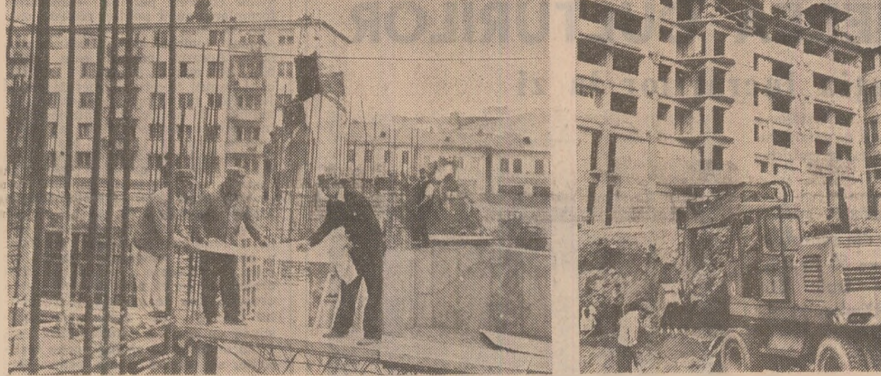
Craiova: Imagine surprinsă ieri pe șantierele de locuințe din zona centrală a municipiului (fotografia din stînga). Blocuri noi de locuințe pe strada Unirii (fotografia din dreapta). Foto: Gelu Giurcă
