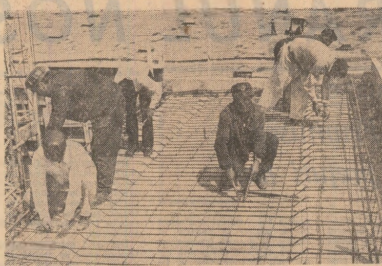
Folosind din plin timpul de lucru, echipa lui Constantin Pisaltu este hotărâtă să termine cât mai repede lucrările de armare a ultimei zone monolite de la acoperișul centralei de climatizare nr. 3
