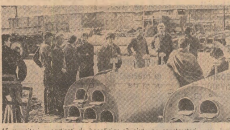
15 muncitori, repartizați de beneficiar să ajute pe constructorii, au însoțit aproape o oră pînă a sosit o macara pentru a ridica utilajele din imagine în vederea montării lor
