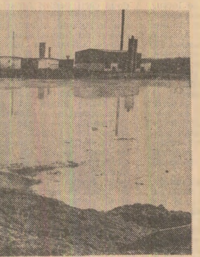
„Vatra nouă”. Cu ani în urmă, pe acest loc era o rampă de depozitare a reziduurilor. A fost înșădit, iar terenul nivelat cu scopul de a fi redat circuitului agricol. Numai că în loc ca aici să răscolă legume sau alte culturi, răscolă gramezi de gunoale care dau locului o înfățișare dezolantă
