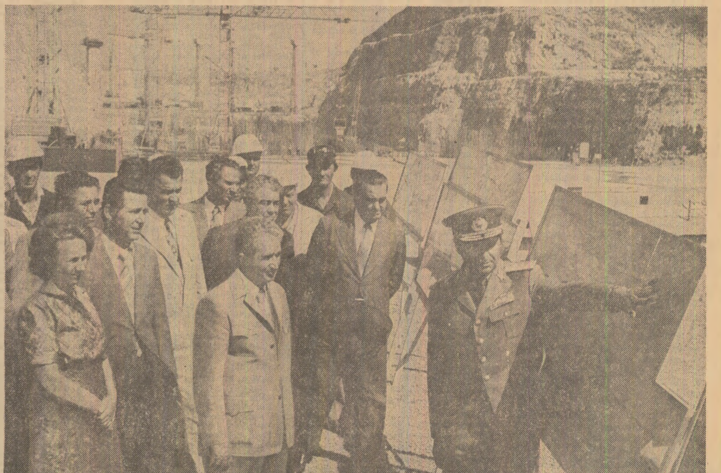
Aci se înalță gigantică ecluza de la Cernavoda
