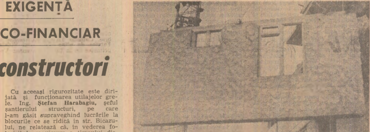
Panouri prefabricate cu un înalt grad de finisare, realizate în secția de producție industrială a trustului
