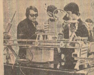
ajutam noi” — a intervenit înstătorul D. Bacu și Mihai Păduraru. Cei patru muncitori s-au apucat de treabă. Ei au realizat în cea mai mare parte din materialele refozibile, panoul solar din imagine, care poate încălzi un rezervor de apă pînă la 70 grade Celsius. Panoul lor este atât de simplu și de ieftin, încît orice gospodăruș poate să-și confecționeze singur.
