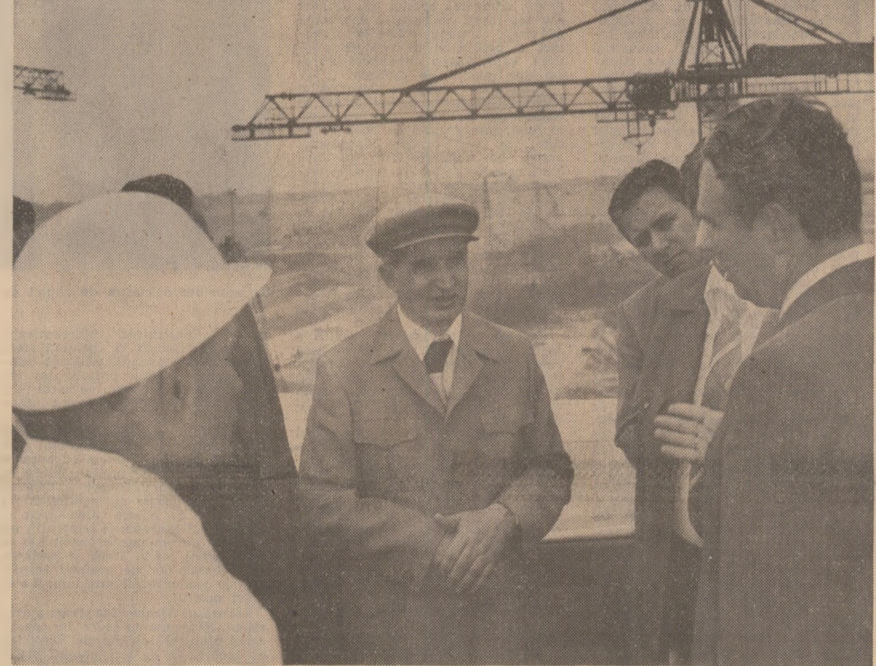
În timpul vizitei pe marele șantier al hidrocentralei Porțile de Fier II
