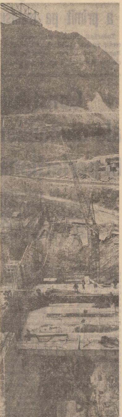
Șantierul hidrocentralei Turcu de pe râul Olt; se lucrează la pregătirea turnurilor betonului la planșeu de la cota 290
