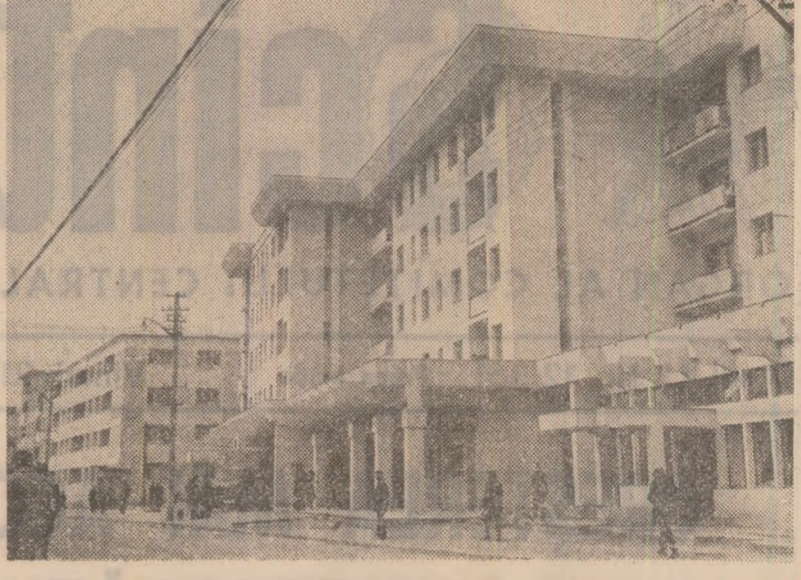
Construcții noi de locuințe la Moinesti. Foto: C. Bursuc
