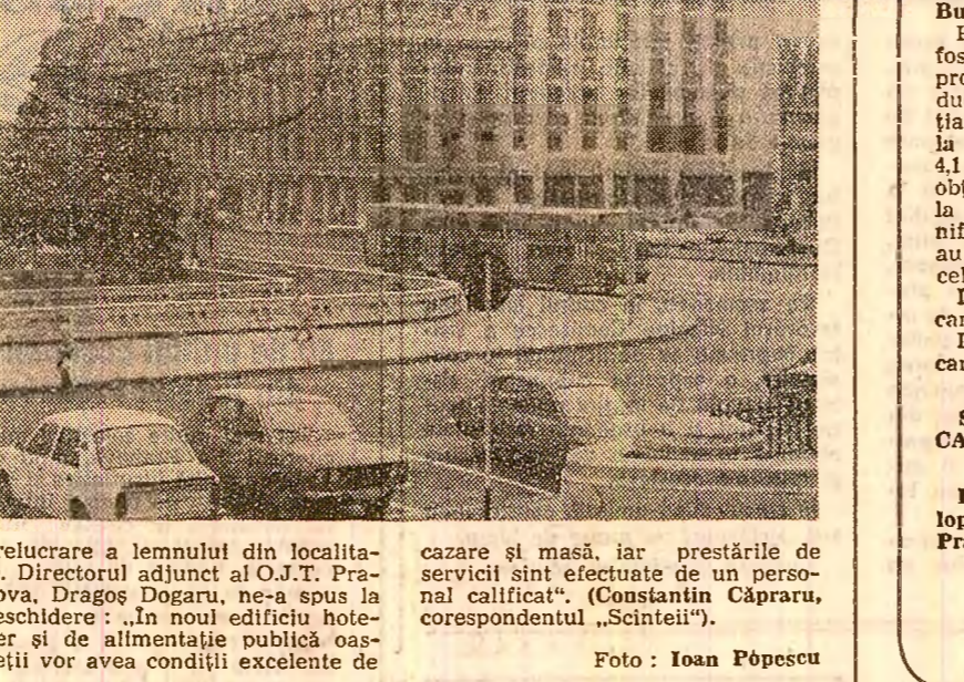
prelucrare a lemnului din localitatea. Directorul adjunct al O.J.T. Prahova, Dragoș Dogaru, ne-a spus la deschidere: „În noul edificiu hotelier și de alimentație publică oaptelei vor avea condiții excelente de
