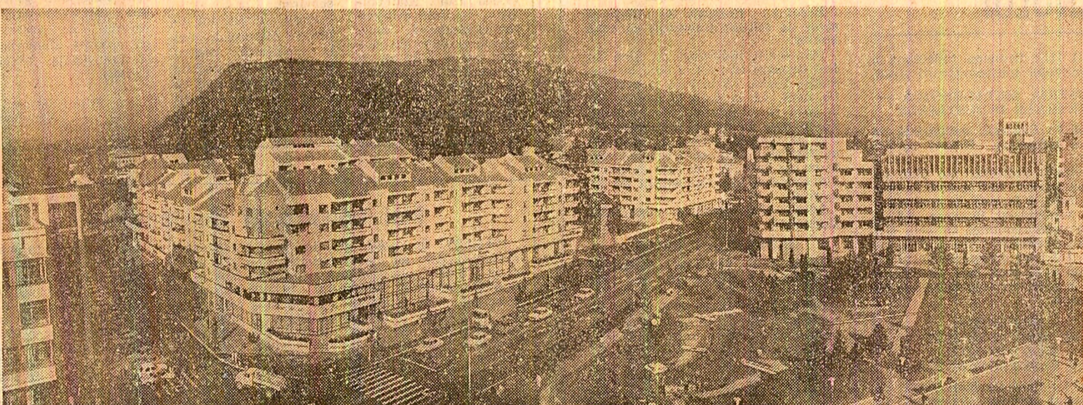
În municipiul Rîmnicu Vilcea, una dintre localitățile țării care au cunoscut în acești ani importante transformări înnoitoare, construcția de locuințe impresionează nu numai prin dimensiunile cartierelor moderne, ci și prin arhitectonică. SECVENȚE DIN IMPLINIRILE ULTIMULUI MANDAT ELECTORAL ÎN ALTE LOCALITAȚI ALE ȚĂRII — ÎN PAGINA A 3-A A ZIARULUI
