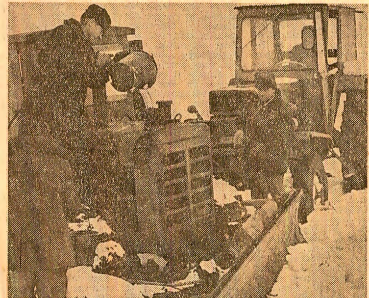
Șantierul Plosca. În primele ore ale dimineții sînt pornite utilajele terasiere care au „înghețat” peste noapte
