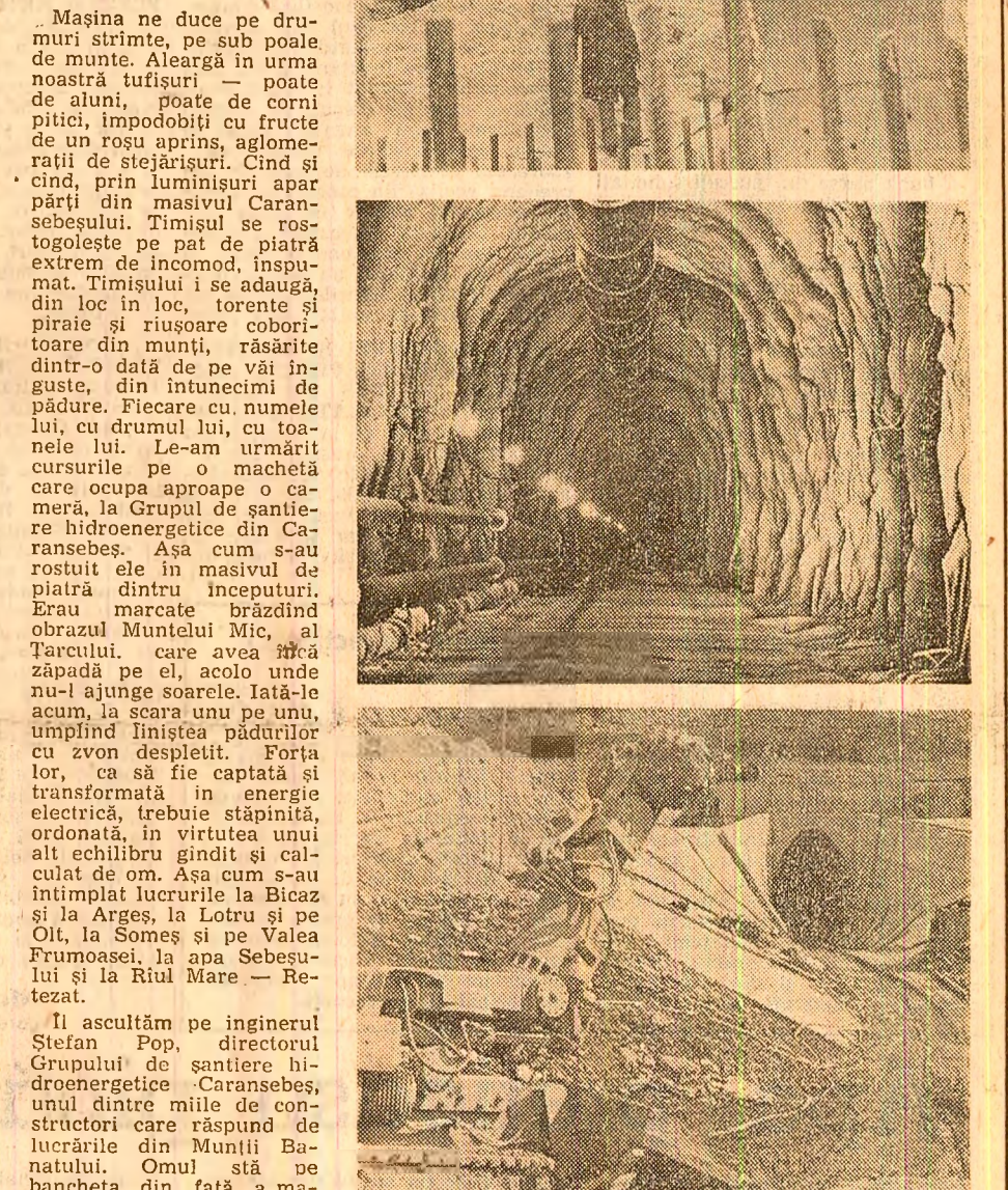
„Drumuri” pentru apele munților Caransebeșului, ducînd spre turbinele viitoarelor hidrocentrale de la Poiana Mărului — Turnu Rueni — Bistra
