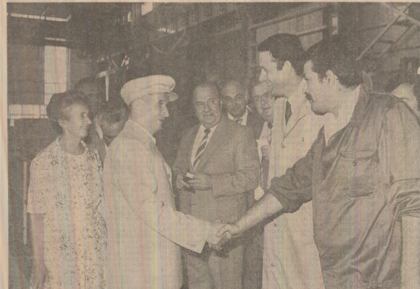
Moment din timpul vizitei de lucru pe șantierul centralei nuclearelectrice de la Cernavodă
