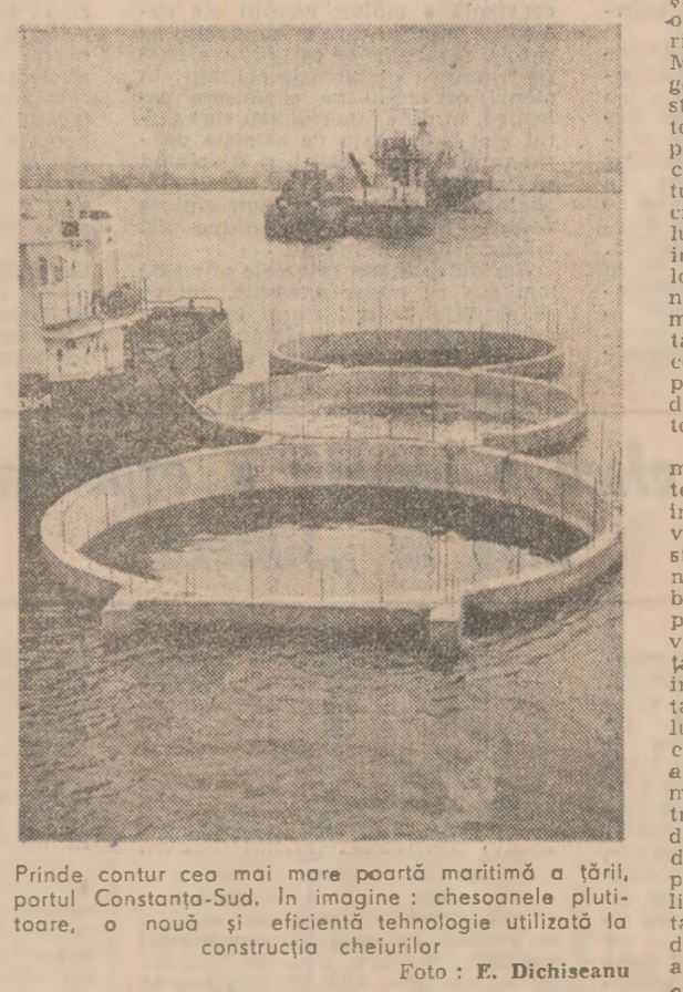
Prinde contur cea mai mare poartă maritimă a țării, portul Constanța-Sud. În imagine: chesoanele plutitoare, o nouă și eficientă tehnologie utilizată la construcția cheilor Foto: E. Dichiseanu
