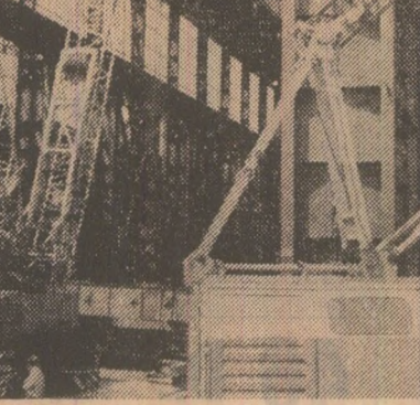
In secția forjă grea de la Combinatul de utilaj greu din Iași a început montajul podului rulant de 500 tone/forjă, una dintre cele mai mari și puternice instalații de ridicat din țară.
