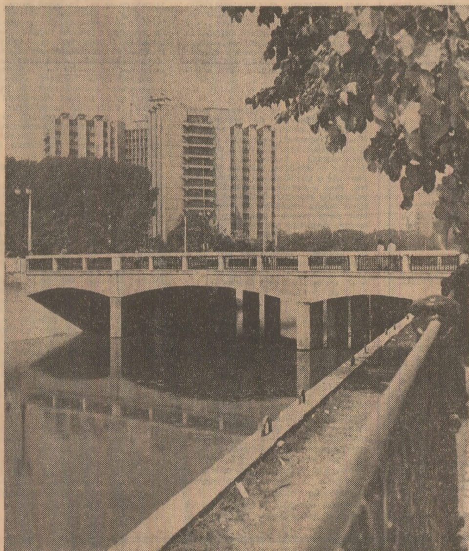
Podul ȘTIRBEI VODA, legătură între două importante zone ale orașului. În planul al doilea, impunătoarea clădire a Spitalului municipal
