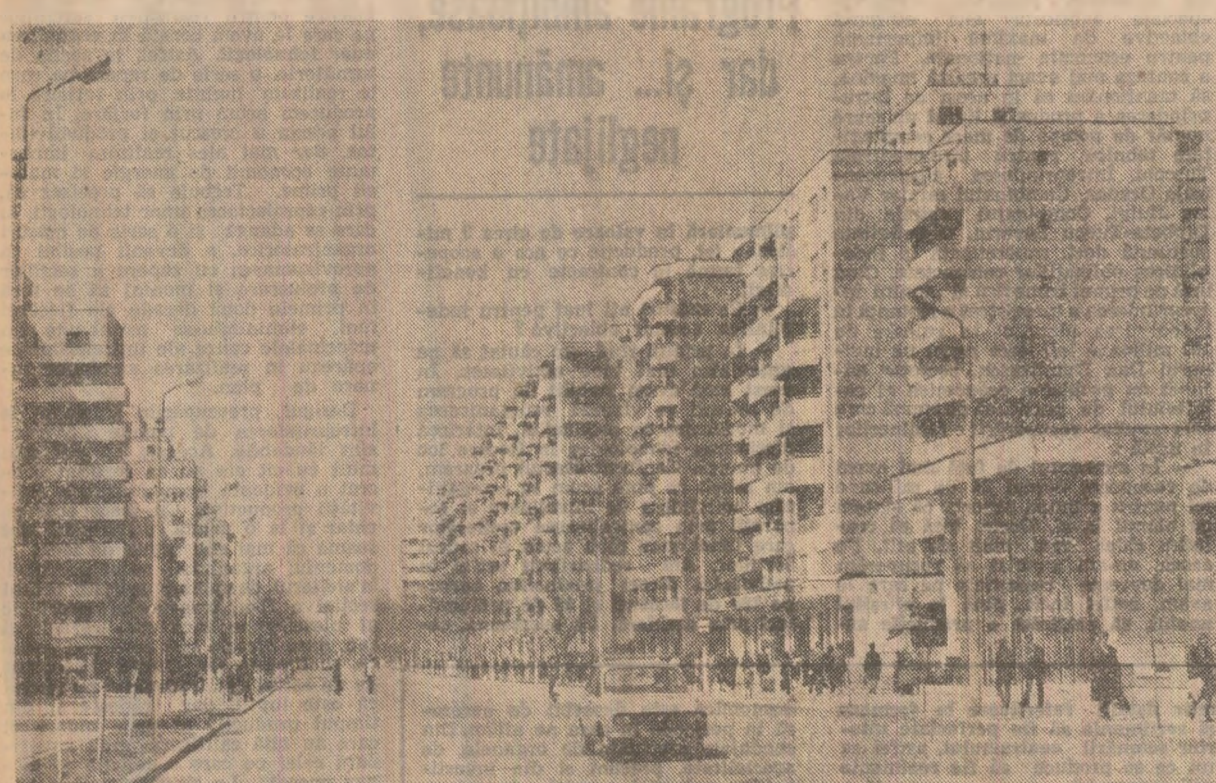
Nou construitiile de locuinte la Slobozia
