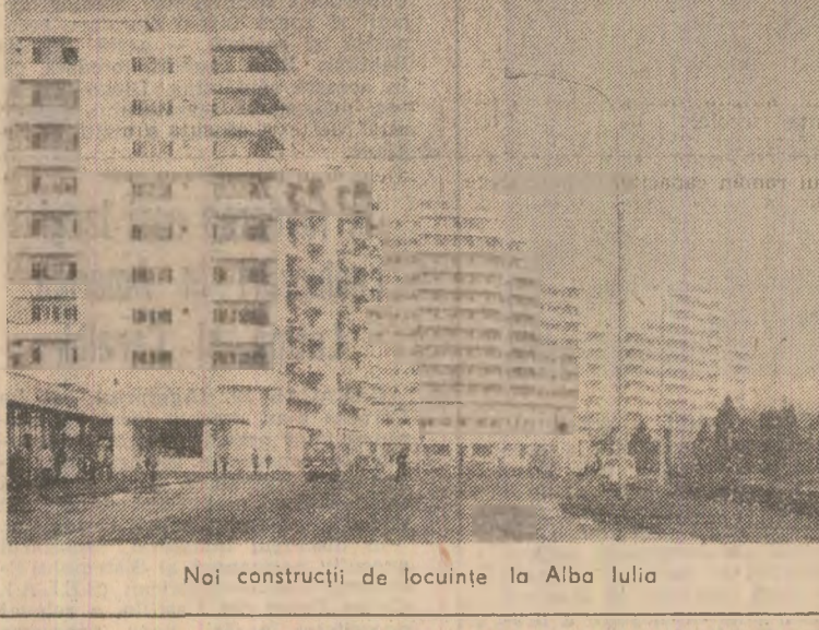
Noi construcții de locuințe la Alba Iulia
