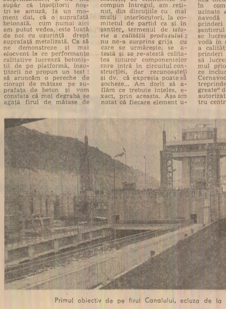
Primul obiectiv de pe firul Canalului, ecluza de la Cernavodă - poarta spre Dunăre a Magistralei Albastre
