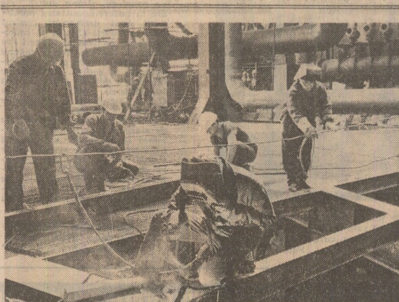
Pe șantierul centralei termoelectrice „Progresul” București, se desfășoară pe un front larg lucrările de construcție și montaj la un nou grup energetic
