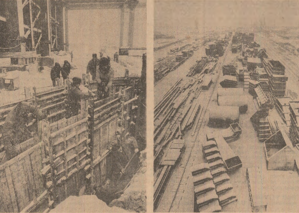
Pe șantier, constructorii au imprimat un ritm intens tuturor lucrărilor. Iată pe dulgheria din echipa lui Dumitru Chirea montînd cofrajele canalului de cabluri din sala cazanelor. În momentul de față, această operație a fost terminată, iar lucrările de betonare s-au efectuat și ele
