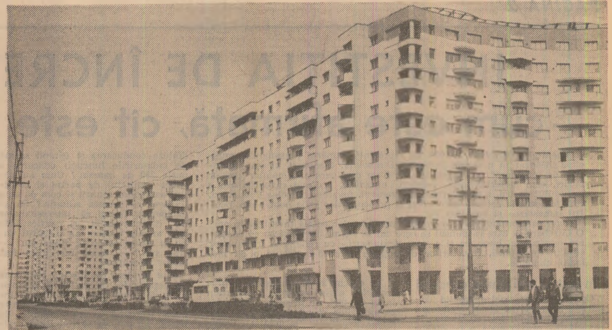
Zilele acestea, în Capitală, a fost dat în folosință un nou ansamblu de locuințe. Foto: S. Cristian
