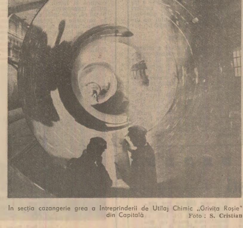
În secția cazangeriei grea a Întreprinderii de Utlaj Chimic „Grivița Roșie” din Capitală. Foto: S. Cristian
