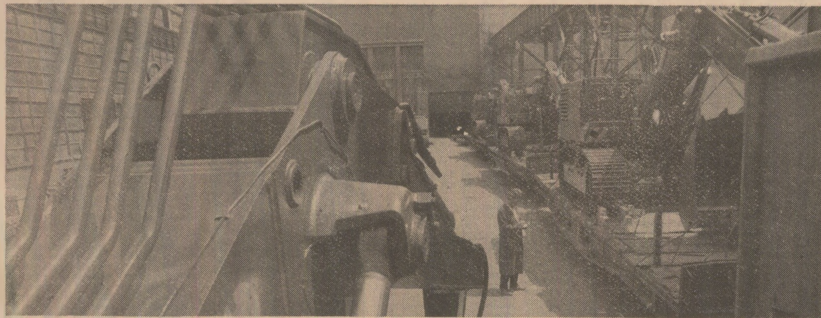
Intreprinderea „Progresul” Brăila. Un nou lot de excavatoare este pregătit pentru livrare
