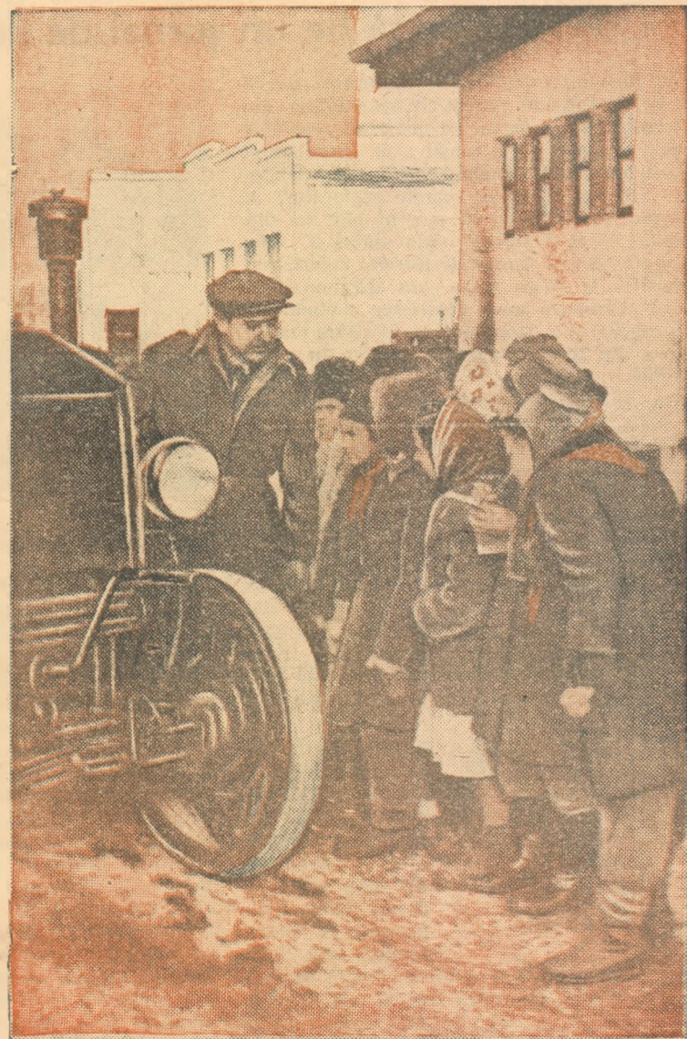
Zilele trecute copiii din clasa a IV-a dela Școala elementară mixtă din comuna Otopeni au vizitat Centrul Mecanic de reparat tractoare și mașini agricole. Acolo au stat de vorbă cu tovarășul Grigore Georgescu dela secția montaj.
