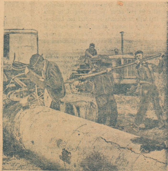
Un aspect de pe șantierul Magistralei de Est
