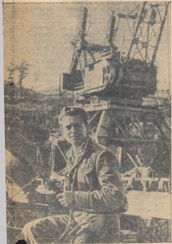
CONTINUT NOI ȘI NOI CONSTRUCȚII SE INALȚĂ PE ÎNTINSUL ALBANIEI
