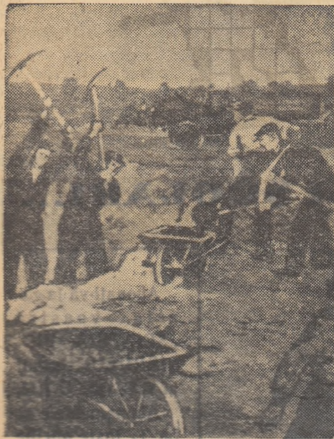
Utemiști muncind cu spor pe unul din șantierele marilor construcții.
