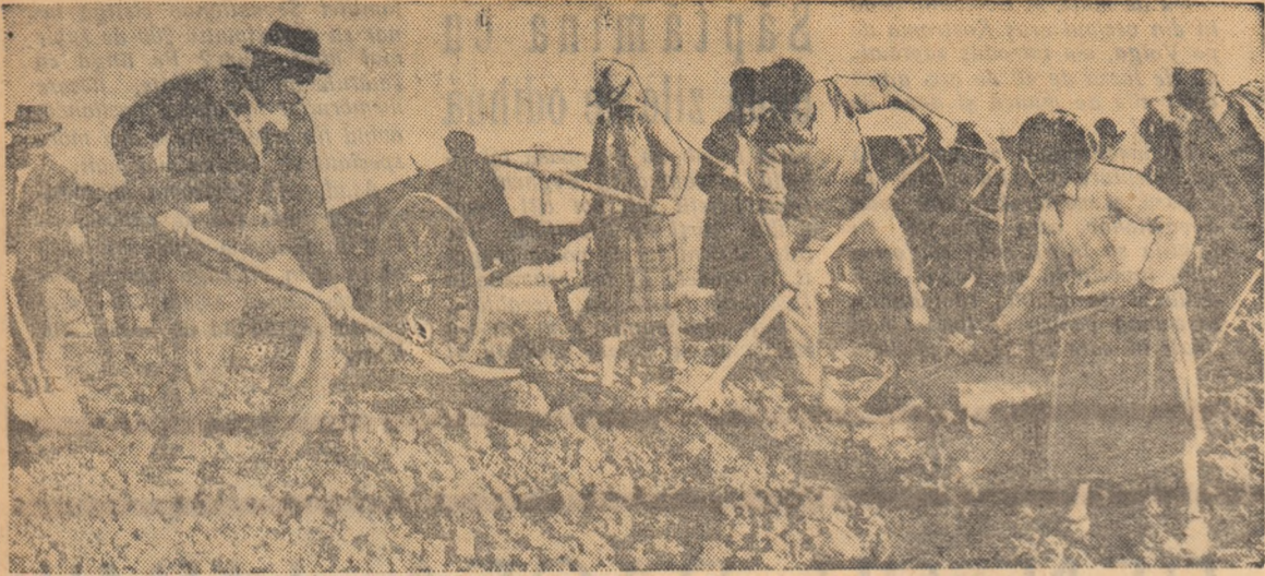
Muncă asvintată pe șantierul de hidroameliorații din comuna Comana — Vidra.
