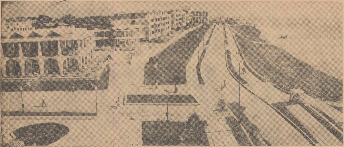
Anul trecut şi-au petrecut concediul de odihnă sau au beneficiat de tratament în staţiuni balneo-climaterice, aproape 600.000 de oameni ai muncii. În foto, impunătoare construcţii înălţate în ultimul timp la Mangalia.
