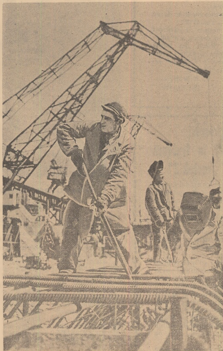
Pe șantierul hidrocentralei de la Botkin, regiunea Permsk-U.R.S.S. constructorii se întrec în muncă în cinstea celui de al XXII-lea Congres al P.C.U.S. pentru titlul de „brigadă de muncă comunistă”. În foto: Brigada Borinov la lucru.
