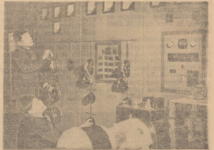
• Cîndva, acești pasionați electrotehnicieni vor lucra poate la un tablou de comandă adevărat, dintr-o mare uzină.
