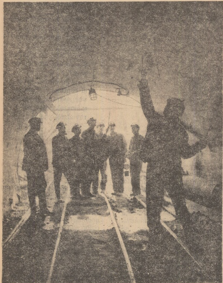
Echipa de electricieni pregătește instalațiile electrice la mina Dilja din Petroșani.
