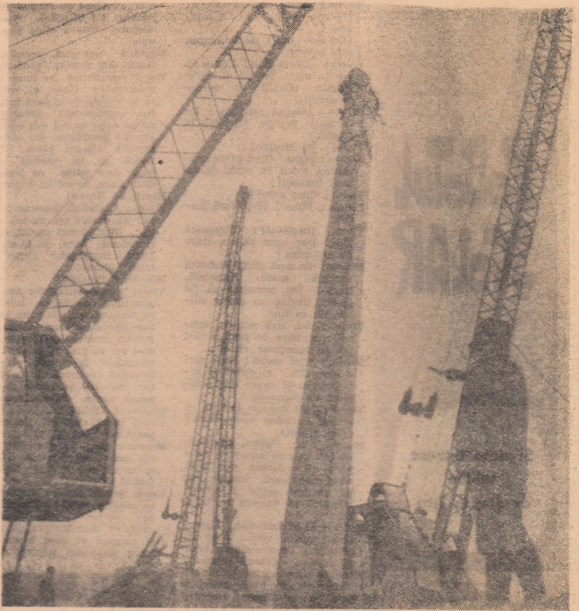
La Turnu Măgurele a răsărit ca în basme o uriașă pădure alcătuită din stâlpi înalți de oțel și beton — panorama industrială a viitorului Combinat de îngrășăminte chimice.
